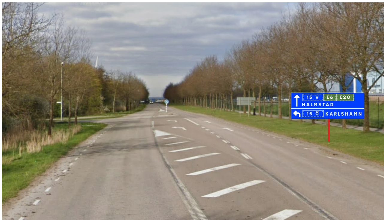
Figur 12. Montage vägvisning åt vänster in på Droskvägen, vy västerut längs Stjärnarpsvägen. Eftersom Kistingevägen ansluter till Stjärnarpsvägen öster om denna korsning, dvs. bakåt i bild, så fångas även relationer från den norra delen av industriområdet som avser åka söderut längs väg 15 av denna vägvisning.
