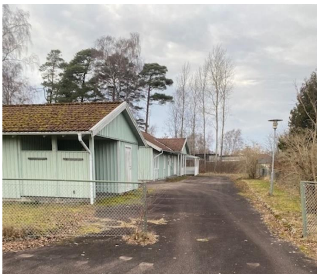
Figur 15. Ingång till nedlagda förskolan på fastigheten (Platsbesök 2025-03-04).
