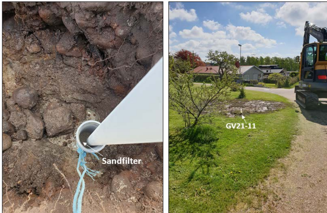
Figur 4. Installation av grundvattenrör i PG21-11 (GV21-11).
