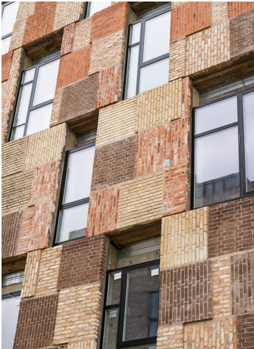
Fasad med återbrukat tegel där brist på likartat tegel lösts med hjälp av en estetiskt tilltalande mixning.
