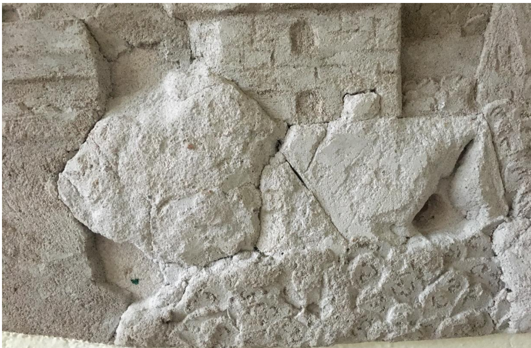
Område i reliefens nedre kant med ytligt materialbortfall.
