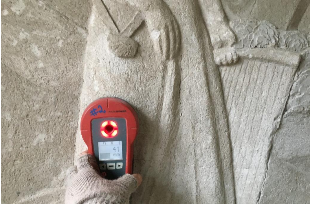
Undersökning av armering med metalldetektor.
