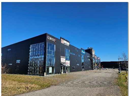
Befintlig byggnation vid Kristinebergsvägen
