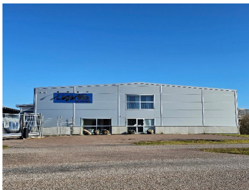
Befintlig byggnation vid Tre Hjärtans väg
