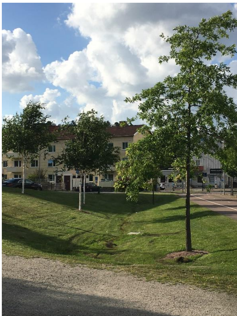
Figur 11. Exempelutformning brett svackdike
