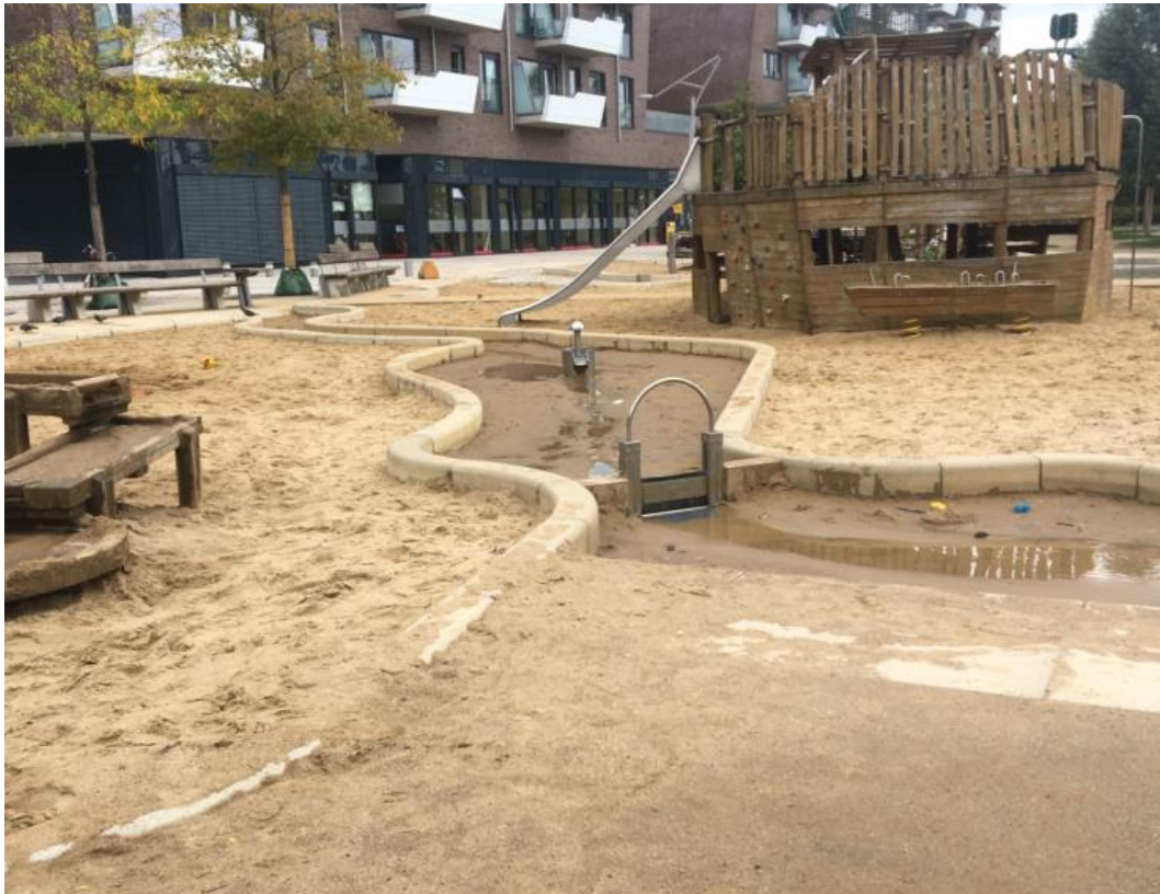
Figur 16. Grund kanal i skolmiljö med stäng- och öppningsbara dämmen (Sweco, 2019).
