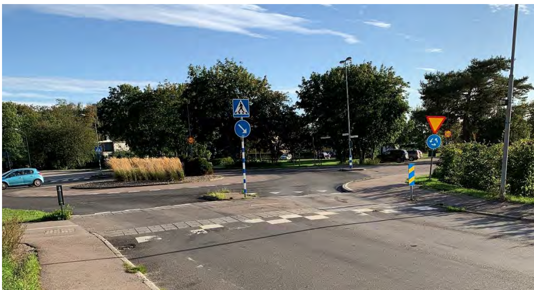
Figur 24. Upphöjd cykelpassage och övergångsställe på Byvägen liknande åtgärd föreslås på Ljungbyvägen i samma cirkulationsplats.
